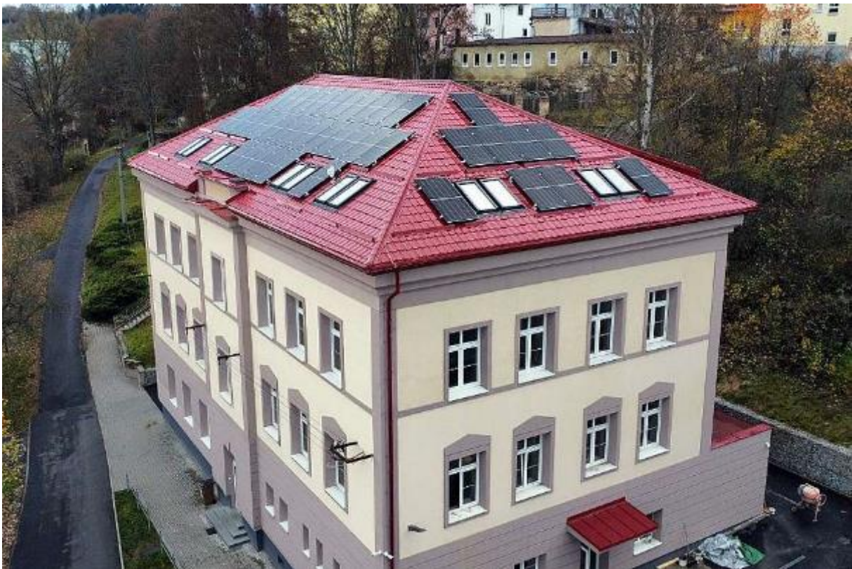
FVE na budově školy v Lubech
